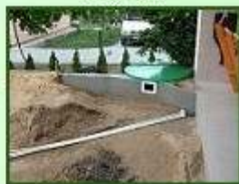
Filtr JFGV/ski - obetonování a příprava
