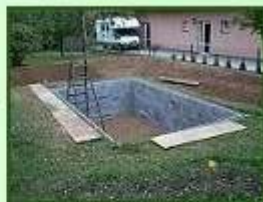
Vyzdění koupací zóny ze ztraceného bednění
